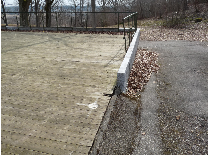
3. attēls. Ēstrādes priekšpusē izveidots asfaltbetona paaugstinājums uzejai uz estrādes.
