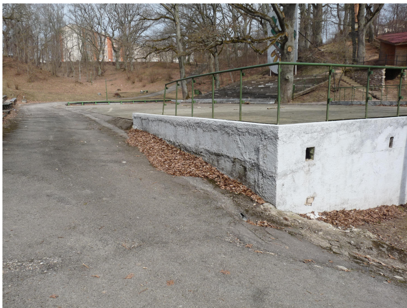
1. attēls. Estrādes pamatiem un sienām izveidots pelēcīgs cementa-smilšu apmetums, kas apmierinošā stāvoklī. Estrādei izveidotas metāla konstrukcijas margas, kas apmierinošā stāvoklī.
